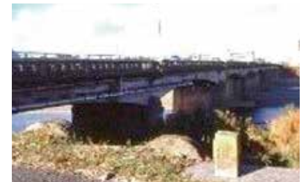
昭和46年完成の関戸橋(上流橋)
