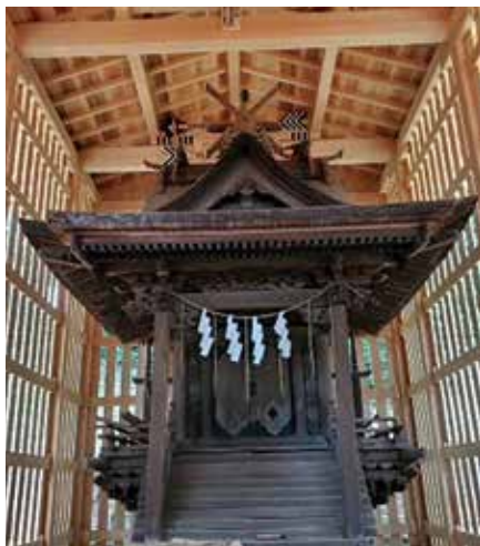
熊野神社本殿 (2022年 改修)
